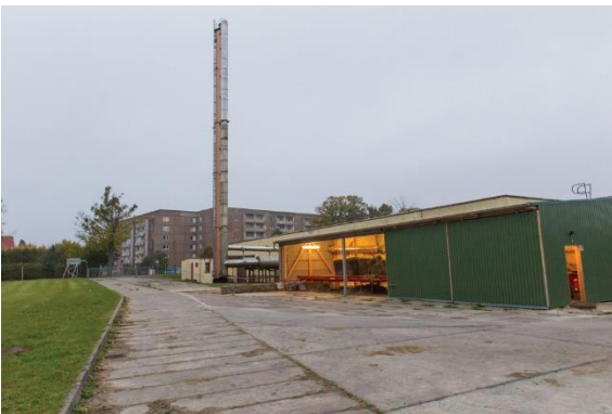
Biomasse-Heizwerk Malchin (M-V) Foto: lensescape.org
